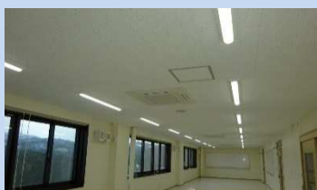
【LED化】人文棟改修
