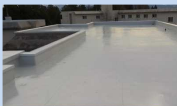
【屋上防水改修】学生宿舍
