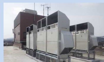
【空調機更新】人文棟改修
