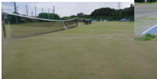
写真上/陸上競技場 トラック改修
