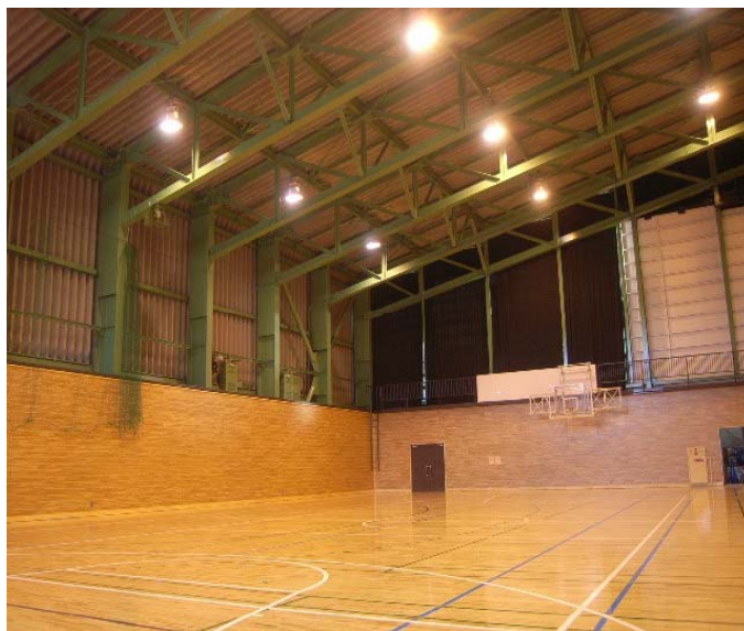
耐震改修が完了した体育館
