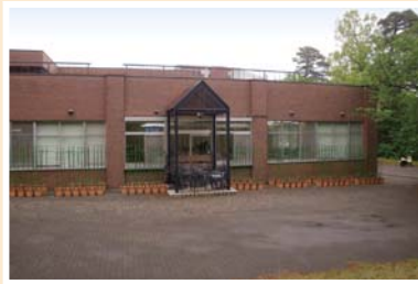
大学会館南側テラス(東側)のプランター配列状況
