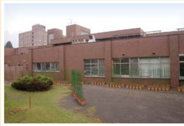
大学会館南側テラス(西側)のプランター配列状況
